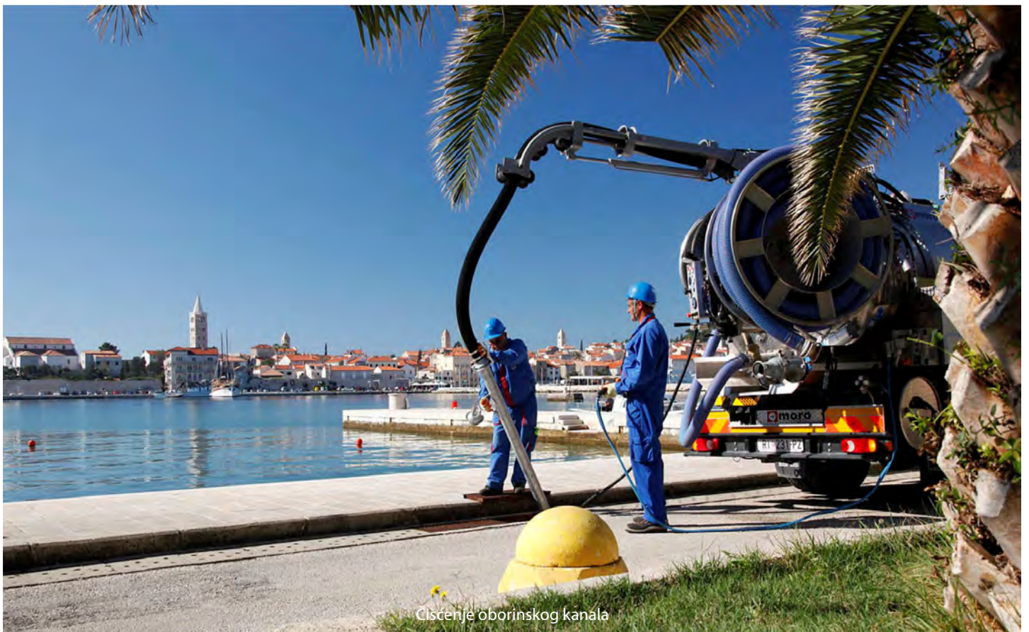
Radovi na sustavu odvodnje
