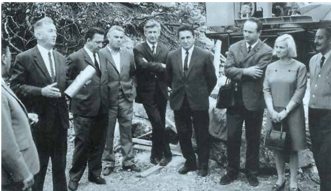
Polaganje kamena temeljca za zgradu Zavoda u Krešimirovoj ulici 52/a (iz fotodokumentacije P. Grabovca)
