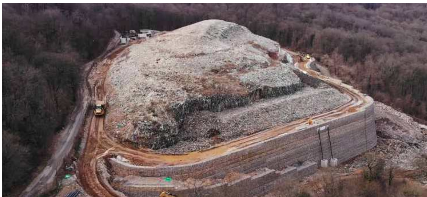
Odlagalište Osojnica u sanaciji
