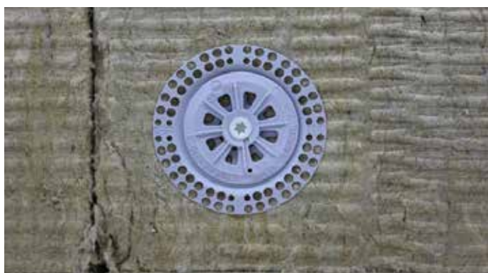
Detalji koji se moraju poštovati kod ugradnje kamene vune i stiropora: pravilno nanošenje ljepila i stavljanje pričvrsnica.
