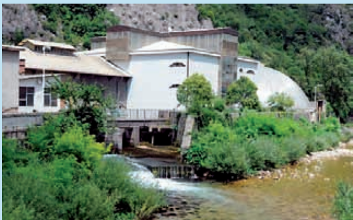
Crpna stanica Zvir
