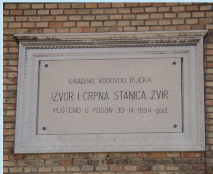
Crpna stanica Zvir
